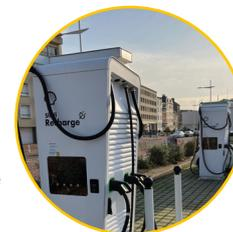
Sur les bornes de recharge DC rapide avec une puissance allant jusqu'à 150 kW, vous pouvez recharger votre véhicule électrique avec une grande quantité d'énergie en peu de temps. C'est parfait si vous avez peu de temps et que vous souhaitez ensuite parcourir de longues distances.
